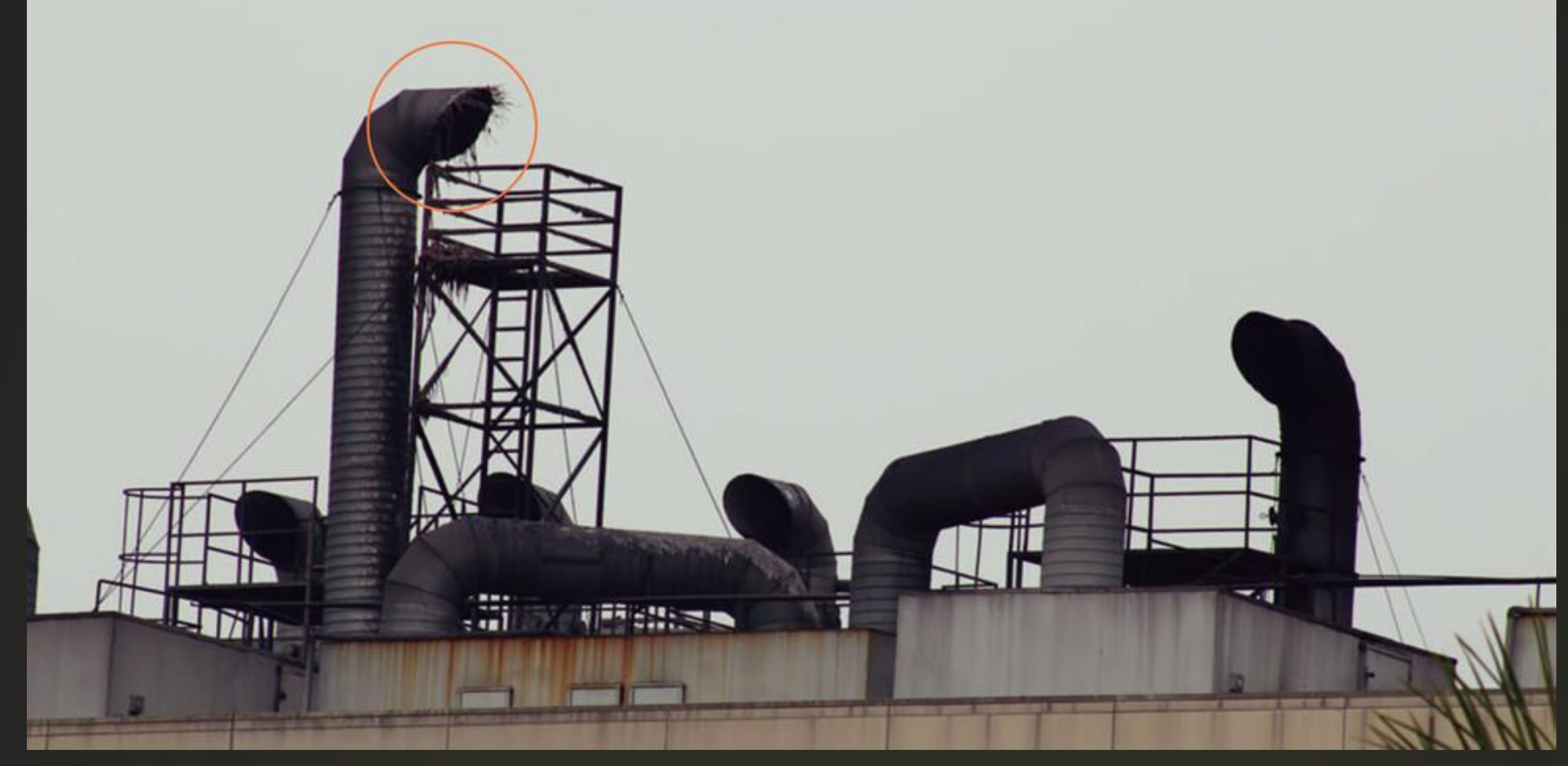
2026년 1~2월 다섯 차례 베트남 삼성 박닌 공장 주변 지역과 1·2차 협력업체 네 곳을 현장 조사. 한 협력업체 굴뚝 입구에 여과되지 않은 고체 형태 화학물질이 붙어 있는 등 방지시설이 제대로 작동하지 않는 정황 확인.
